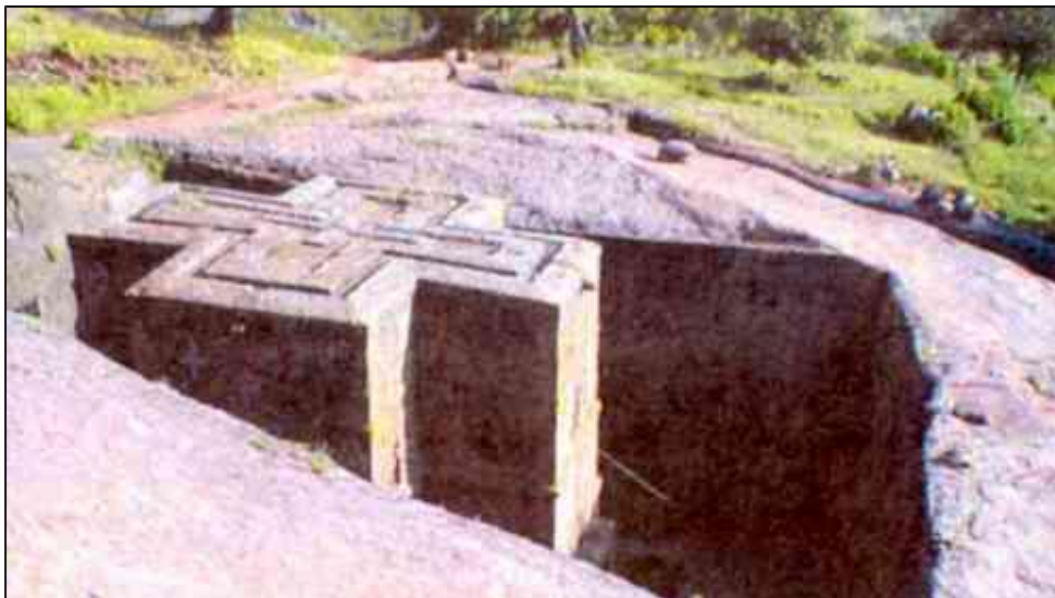
mit Hammer und Meißel ins Tuffstein getrieben
